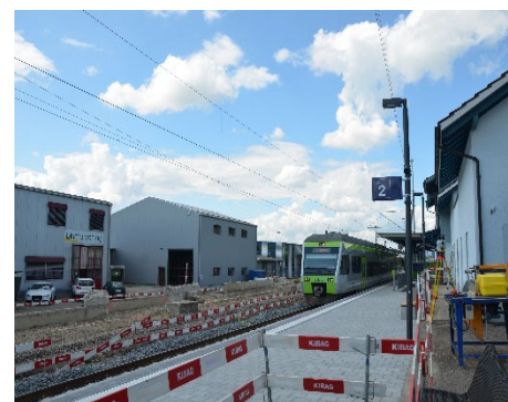
Wir bauen für Sie: Modernisierung Bahnhof Madiswil
