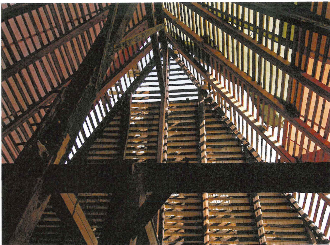
19 Freilichtmuseum der Schweiz, Bauernhaus aus Madiswil BE. Die teilweise alte und stellenweise erneuerte Dachkonstruktion über dem Stall. Aufnahme 2009.
