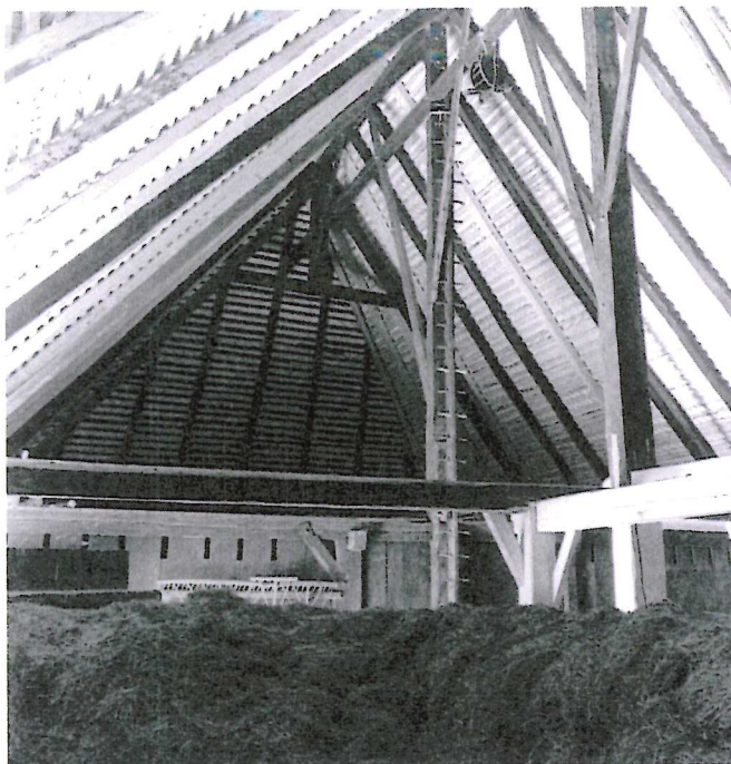
12 Freilichtmuseum der Schweiz, Bauernhaus aus Madiswil: Innenraum des Ökonomieteils mit gut erkennbarer die Hochstuckkonstruktion. Aufnahme nach 1975.
